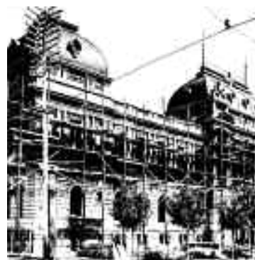
El edificio en construcción
