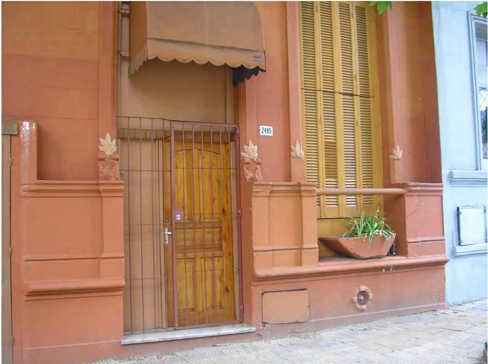
Foto 1: Fachada del edificio
