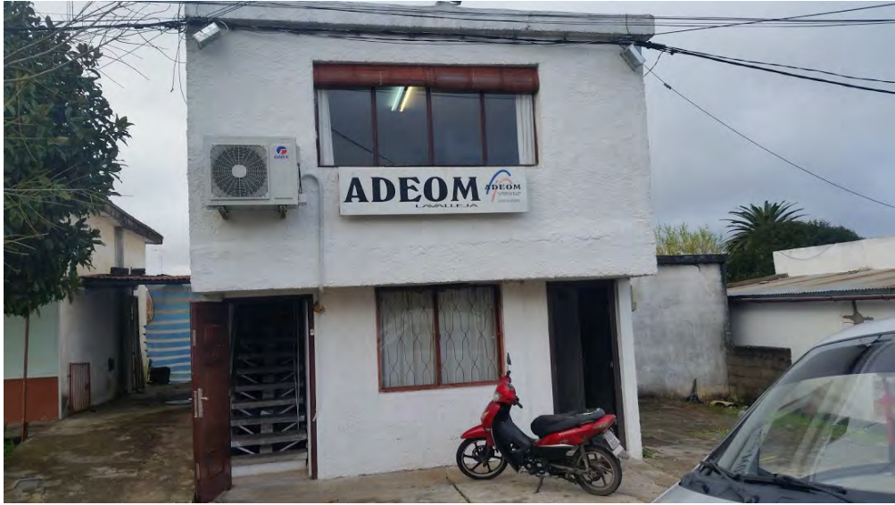
Foto 1: Fachada del edificio de ADEOM Lavalleja
