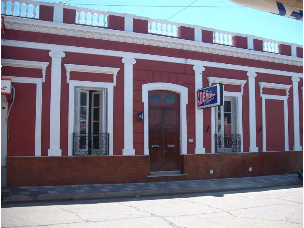
Foto: fachada principal
