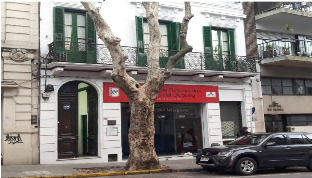
FOTO 1: Fachada del Edificio
